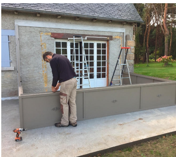
L'entreprise peut assurer le montage des serres. Ici, un assemblage des soubassements en aluminium.
